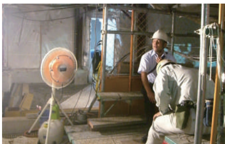
屋内(休憩所)(熱暑対策)
