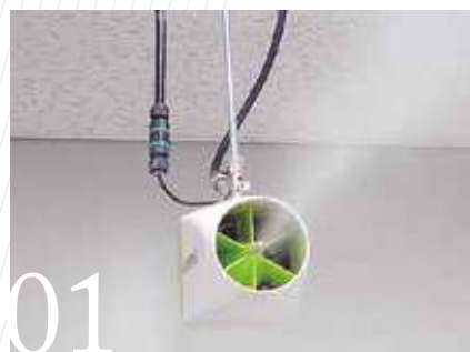
01 加湿器は天井吊り下げで場所をとらない
