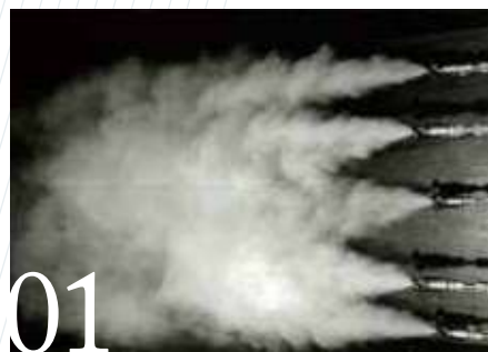
01 空調機内加湿の様子
