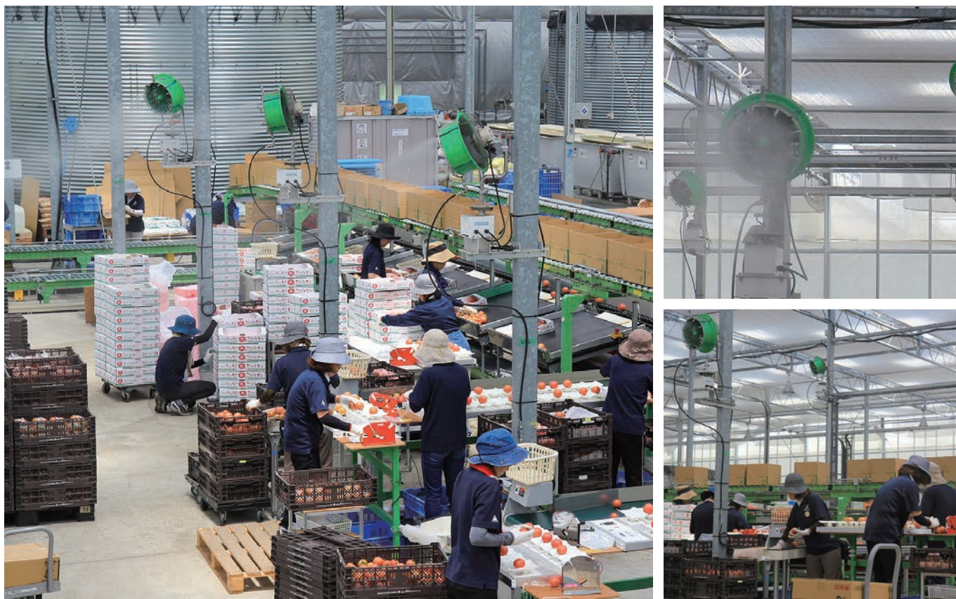
▲大規模な施設園芸の建屋内に導入。作物や出荷箱、作業者を濡らすことなく、しっかり冷房できている。
