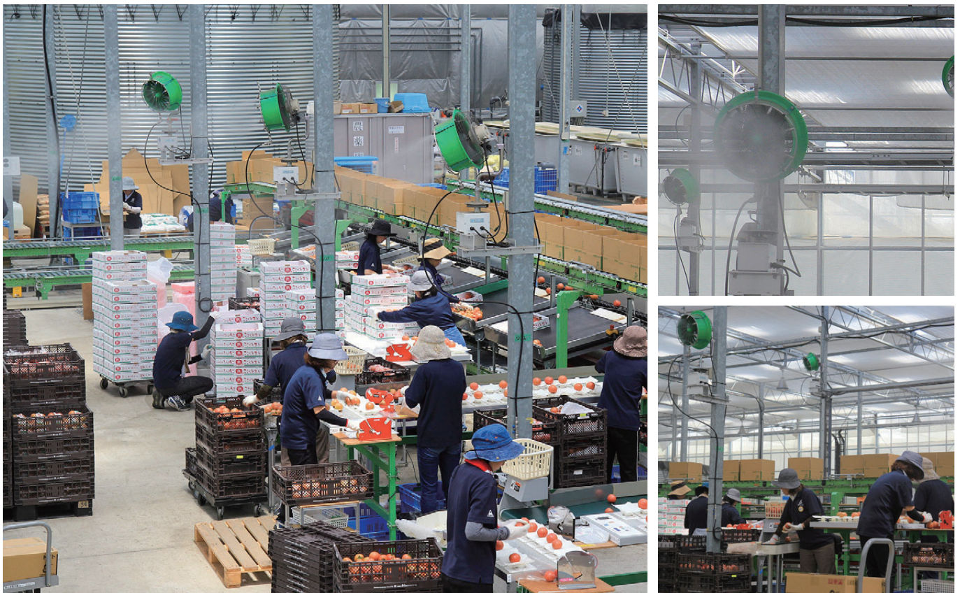
▲大規模な施設園芸の建屋内に導入。作物や出荷箱、作業者を濡らすことなく、しっかり冷房できている。
