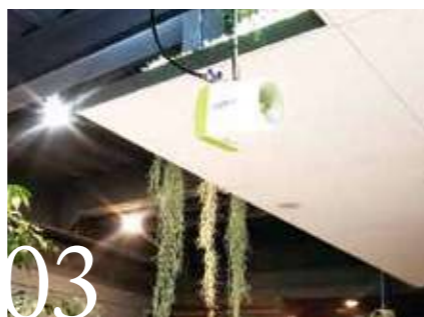
03 オフィス・作業管理室
