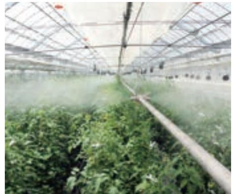
温室内冷房加湿システム CoolPescon<sup>®</sup>CH
